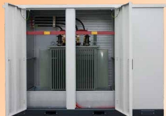
Traforaum mit Drehstrom-Öltransformator einschließlich Ölauffangwanne oder mit Gießharztransformator. Leistungen, je nach Gebäudetyp, bis zu 1600 KVA. Kabelverbindung zum Gerüstverteiler mit kurzschlussfester Leitung. MS-Anschluss über Kupferanschlusslaschen mit Phasenfestpunkten für die Erdung des Transformators einschließlich Erdungsfestpunkt im Traforaum
